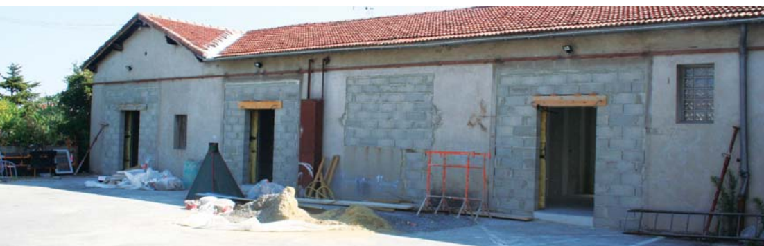
Fin août, on attaque la finition des travaux
